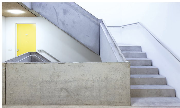
Treppenaufgang © Till Schuster
