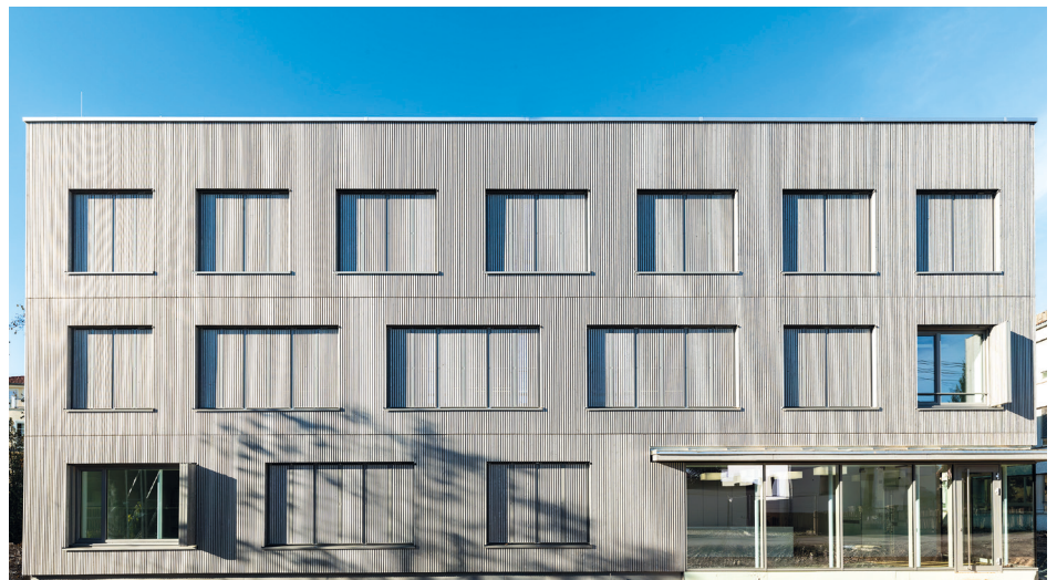
Südansicht des Dienstgebäudes mit geöffnetem Sonnenschutz (oben) und geschlossenem Sonnenschutz (unten) © Achim Bunz
