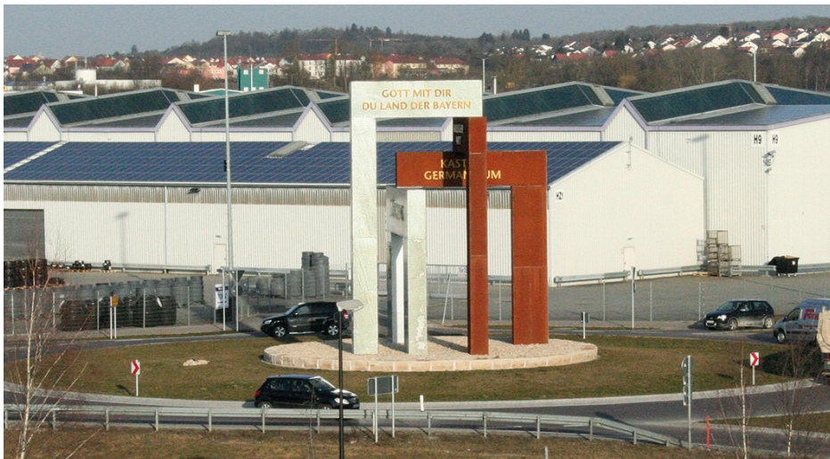
Kreisverkehr bei Kösching im Landkreis Eichstätt © Staatl. Bauamt Ingolstadt
