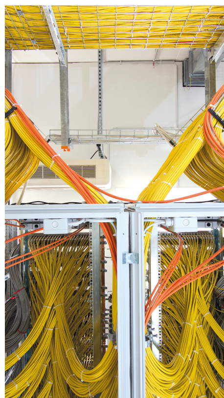
EDV-Netzunterverteiler im Neubau des OP-Zentrums in Großhadern © Klaus-Reiner Klebe, München
