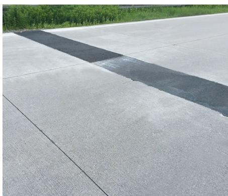
Entspannungsbereich in Asphaltbauweise © Autobahndirektion Südbayern
